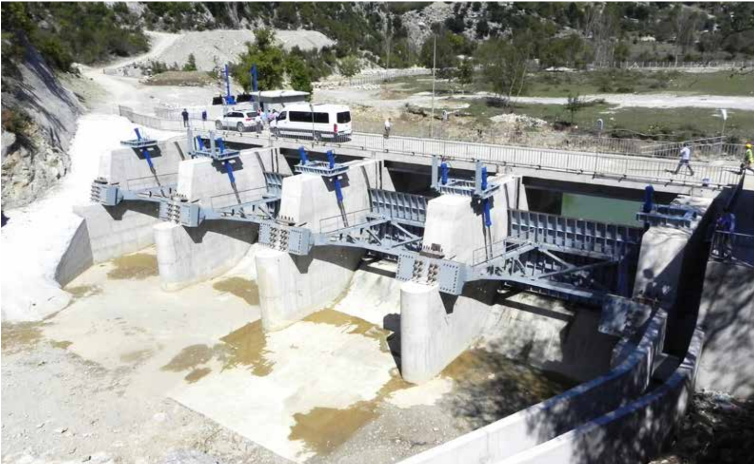
Kalealtı II HEPP, Türkiye (13,8 MW) Contractor: TEKTUĞ A.Ş
